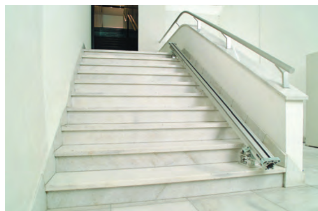
斜め切断および階段切断サポートによるレールサポート取付け
