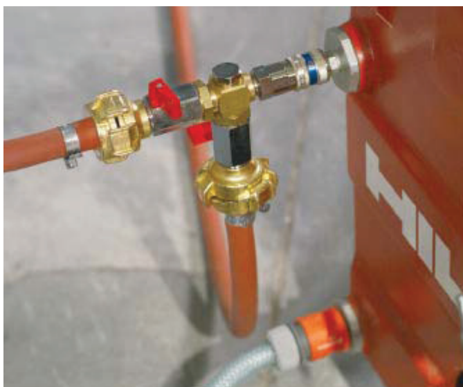
Pripojenie vodných hadíc.
