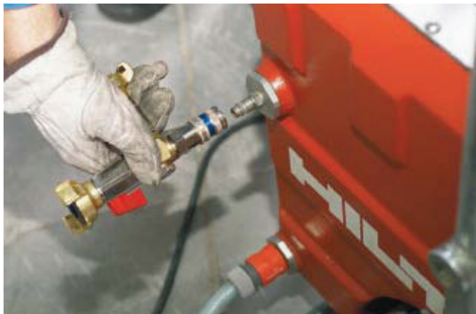
Montáž rozdeľovača vody.
